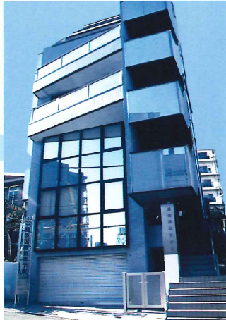
▲ 本校舎 Main Building
